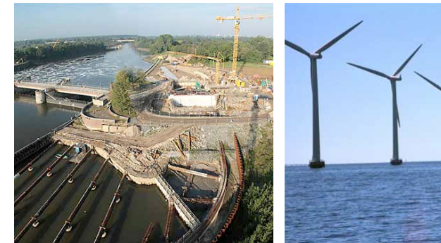
im Bau befindliches Wasserkraftwerk in Bremen, Offshore-Windpark
