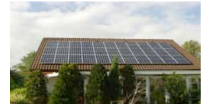
4 kW-Solarstromanlage auf privatem Dach. Quellen: Martin Bucher, SolarKonzept
